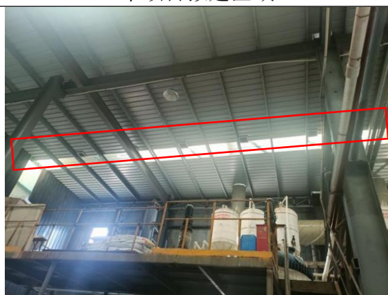
1#生产单元废气收集设施
